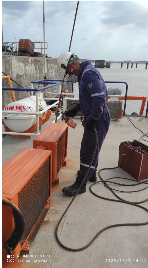
Figura 22: Pintura das unidades externas dos aparelhos de ar condicionado.
