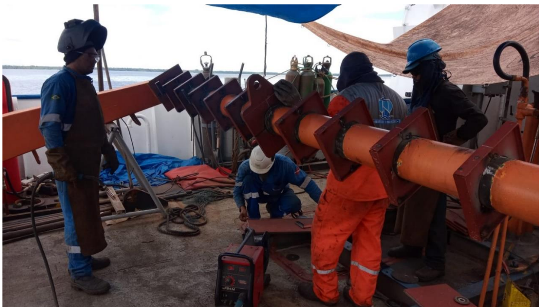
Figura 4a) Suportes de aço sendo montados na viga do A-frame para aumentar a sua capacidade de carga, evitando uma flexão indesejada.
