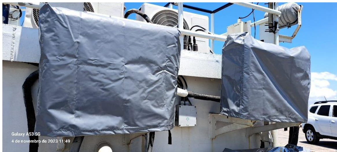
Figura 19: Proteção das unidades externas dos aparelhos de ar condicionado.
