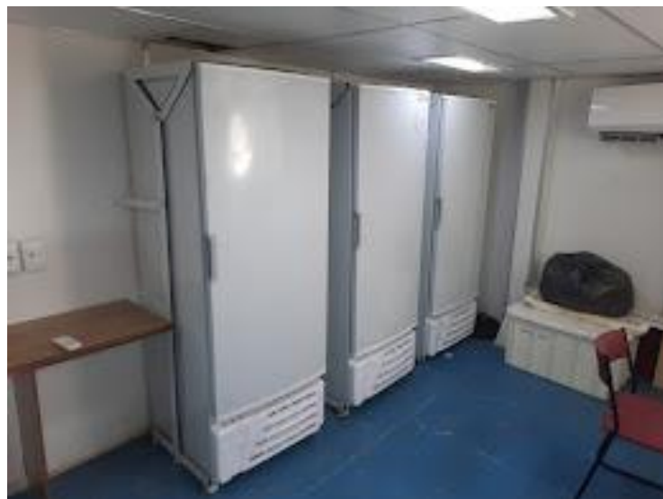
Figura 4a) Freezers instalados no Laboratório Seco.
