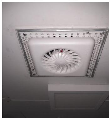
Figura 33. Instalação de exaustores nos banheiros.
