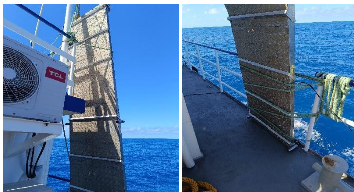
Figura 46. Serviço de fabricação de rampa de acesso.
