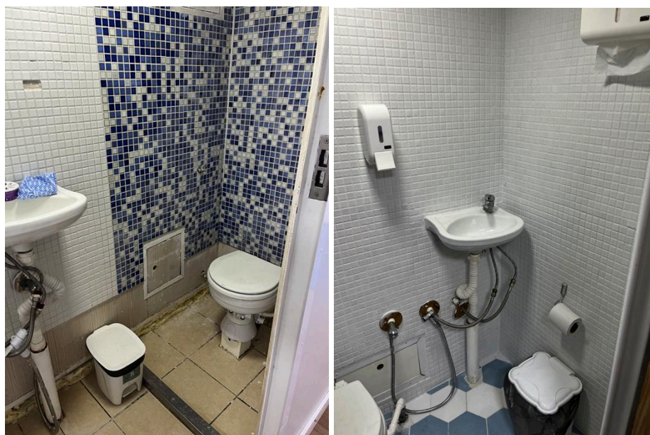
Figura 6. Serviço de colocação de pastilhas para evitar infiltração nos banheiros.
