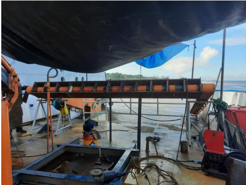
Figura 4b) Suportes de aço sendo montados na viga do A-frame para aumentar a sua capacidade de carga, evitando uma flexão indesejada.
