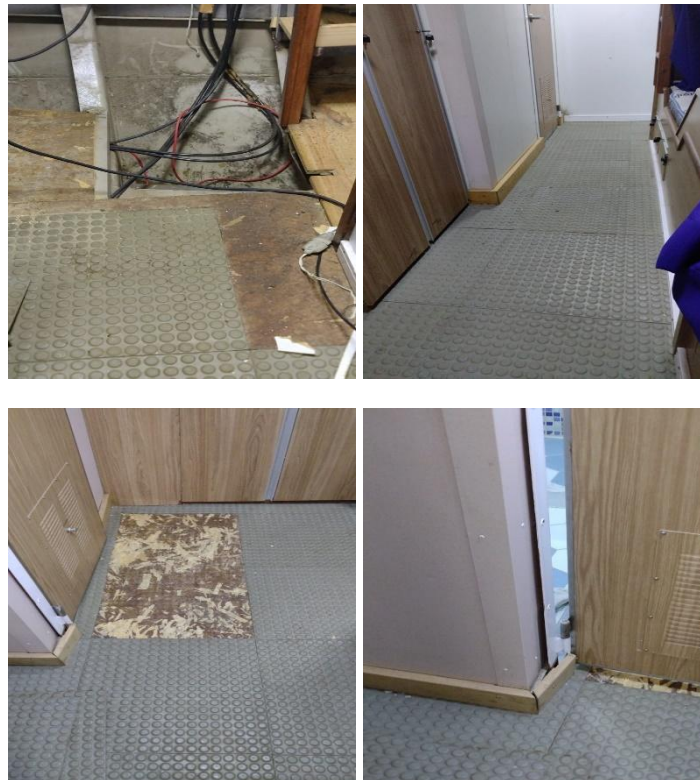
Figura 11. Reparo nos pisos dos camarotes.
