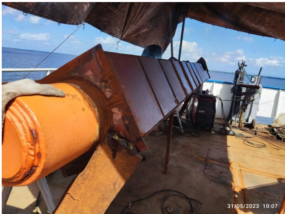
Figura 4c) Serviços de solda no A-frame quase concluídos.
