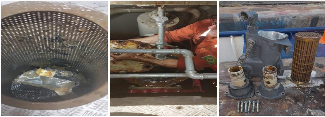
Figura 13. Limpeza dos trocadores de calor e das caixas de mar
