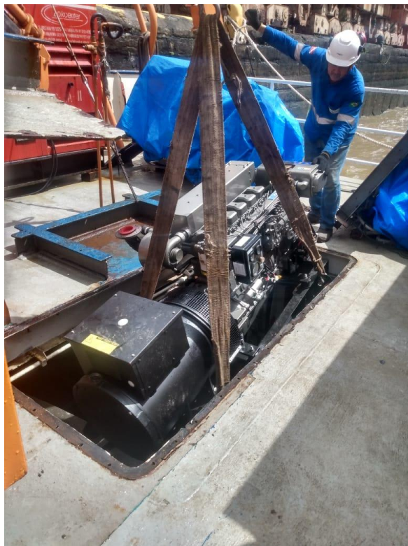
Figura 5c) Embarque dos dois geradores no NEP CM II.
