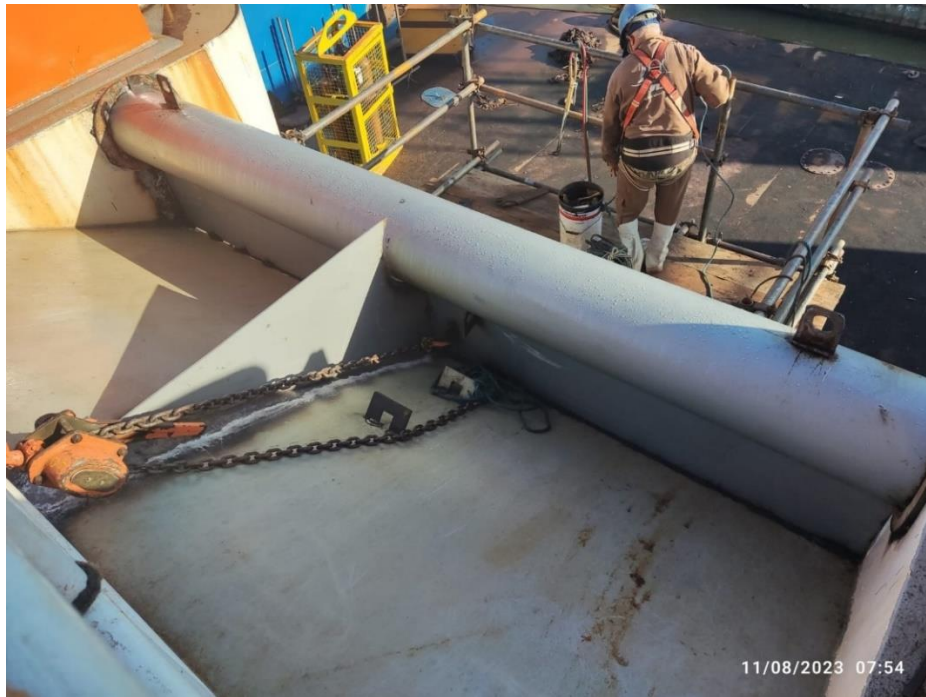
Figura 10 a) Montagem da estrutura de apoio da expansão da popa do NEP CM II.
